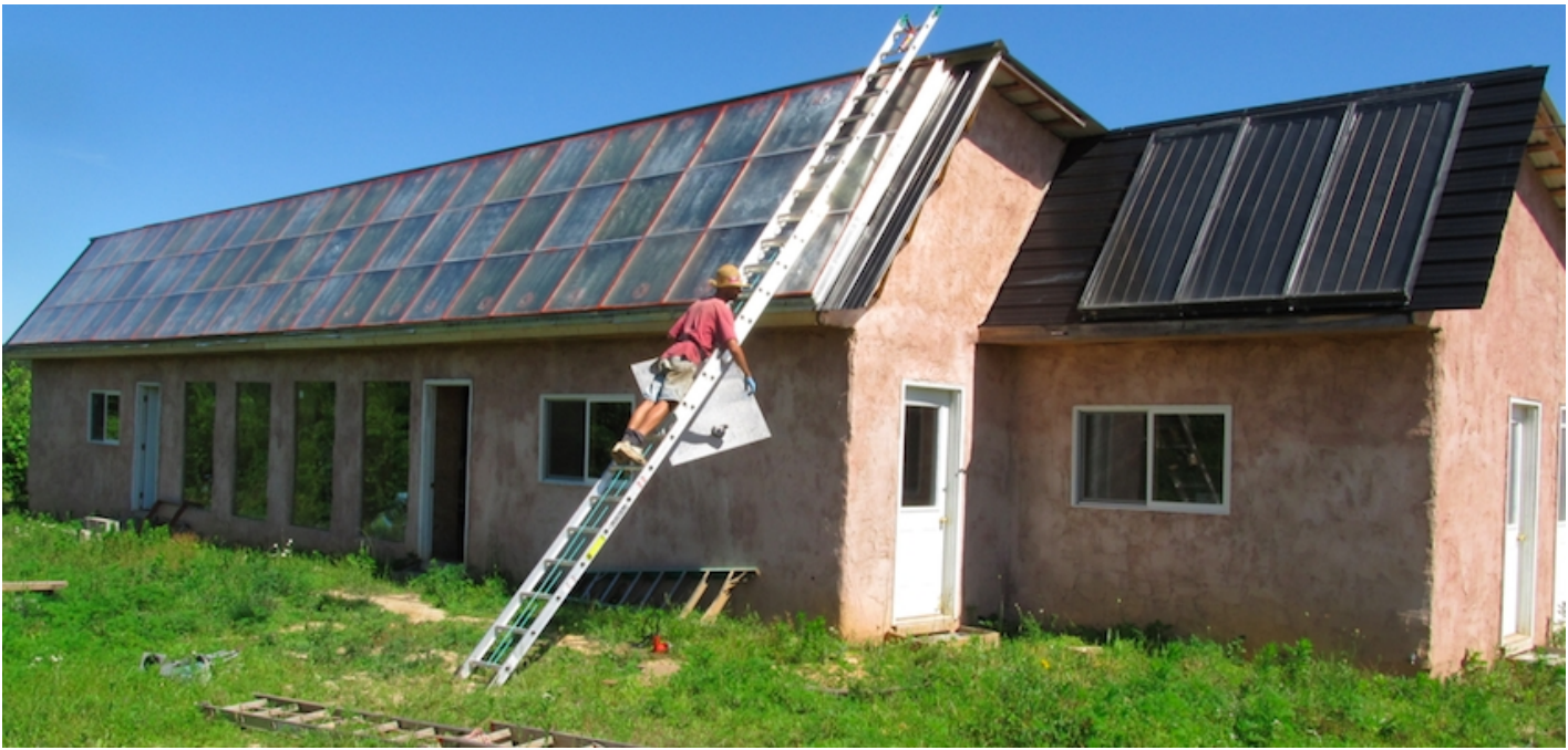
Installation d'une vitre sur un capteur solaire à air chaud solaire
